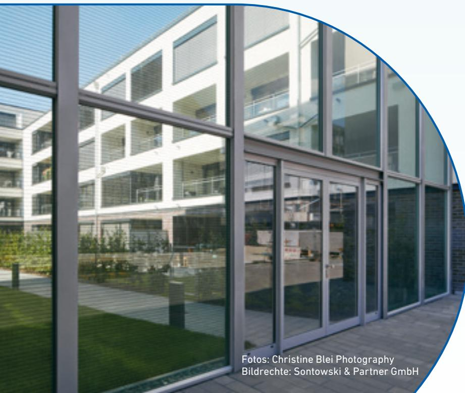
Für eine dreiseitig lärmbelastete Wohnbebauung wurden 214 bodentiefe Hafencity-Fenster verwendet, um den äußeren Lärmpegel im teilgeöffneten Zustand von 66 dB auf 30 dB Innenraumpegel zu senken.
